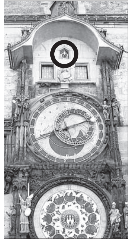
KOHOUT trůní nad časem i svatými.
